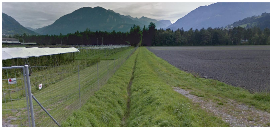
Abbildung 9: Nollakanal flussabwärts (Cazis) zur Verdeutlichung der Charakteristik des Gewässers und der Wasserführung – Google Street View (Sept. 2014)
