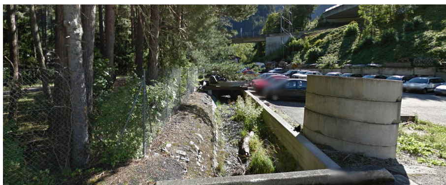
Abbildung 8: Nollakanal im Gebiet der geplanten Erweiterung des Feuerwehrübungsgeländes – Google Street View (Sept. 2013)
