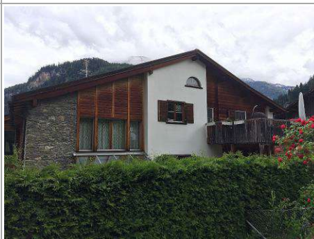
Rückwärtige Ansicht - rechts der Strickbau
