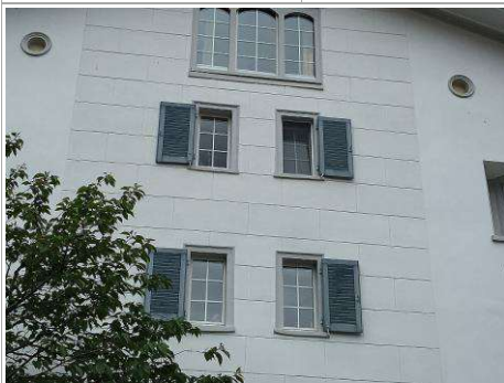
Mittelrisalit mit Rustikabändern
