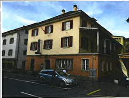
Ansicht von Südwesten mit Laube über Anbau
