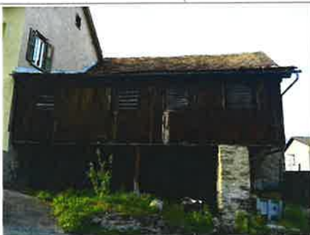
Ansicht von Süden mit Vorbau
