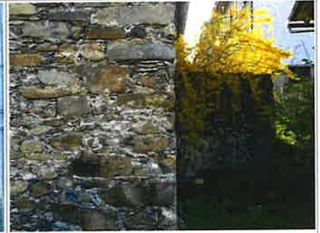
Nordostecke des Stalls und Scheuneneinfahrt
